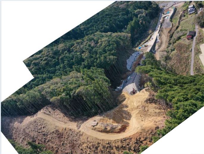
処分場側から国道方面の状況（令和7年4月14日撮影）
