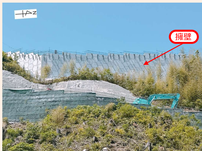
擁壁の整備状況（令和7年5月13日撮影）
