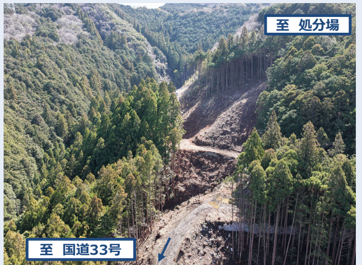
国道側から見た整備状況（令和8年3月4日撮影）
