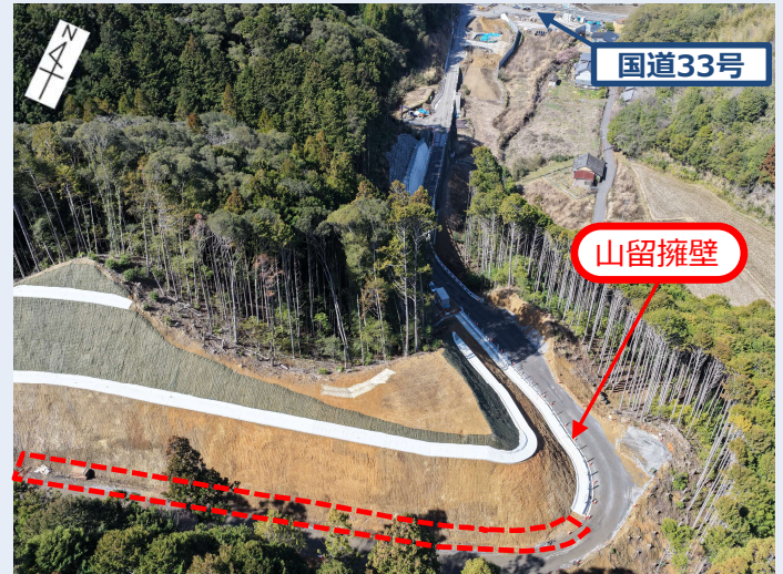
処分場側から国道方面の状況（令和8年3月4日撮影）
