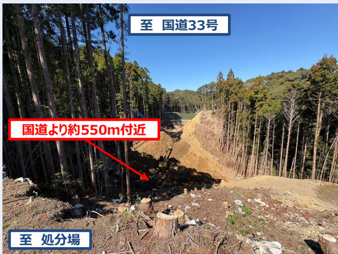
処分場側から見た整備状況（令和8年3月11日撮影）
