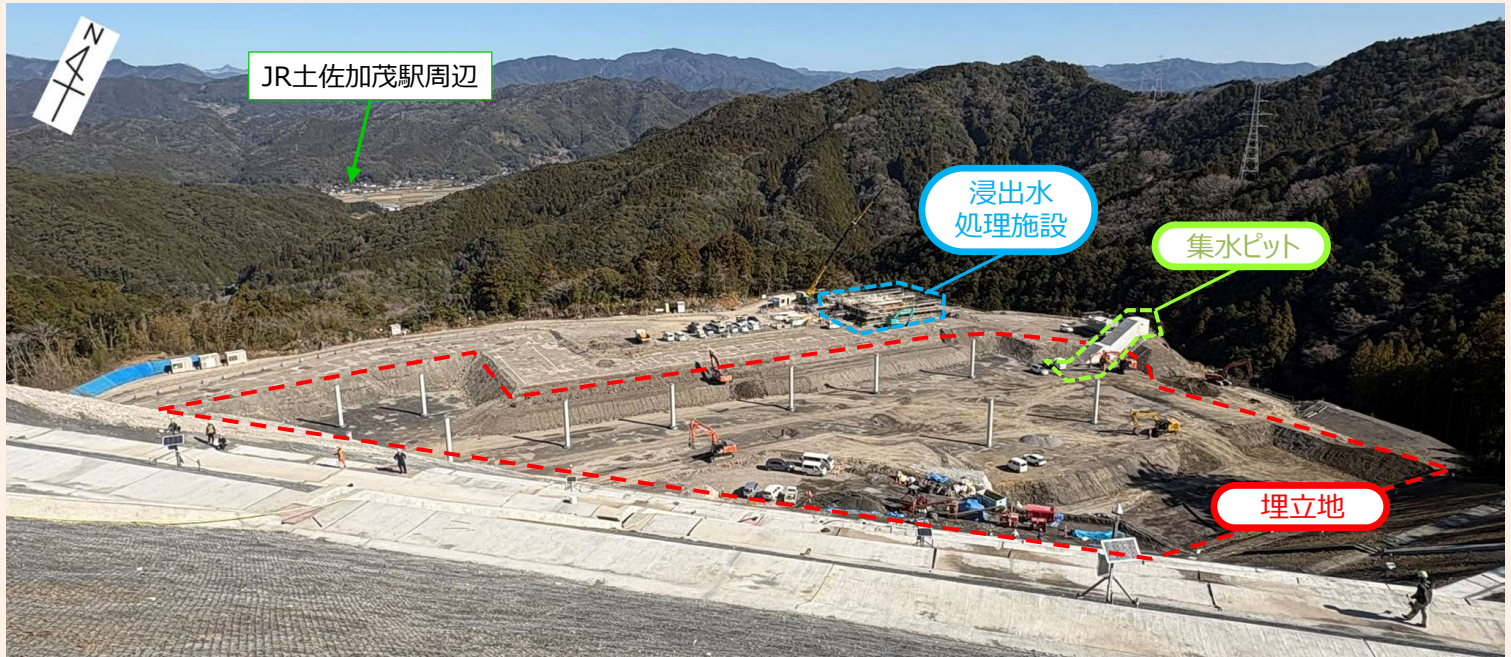
工事区域を南側斜面から見た状況（令和8年3月11日撮影）
