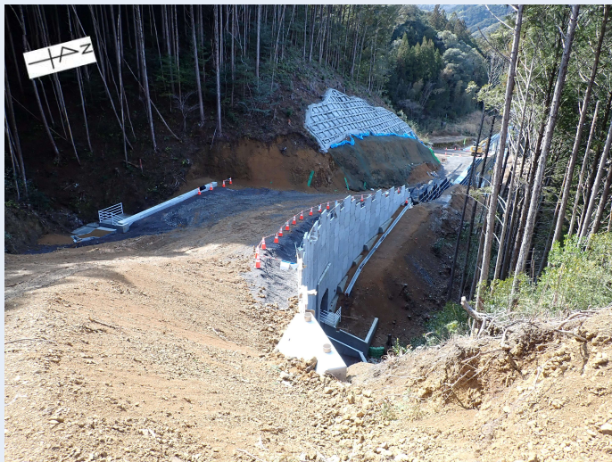
国道から約250m付近の整備状況（令和7年3月4日撮影）
