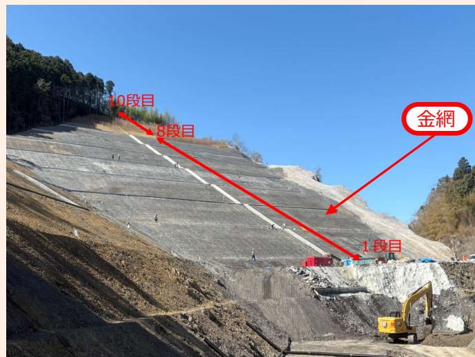
南側斜面の整備状況（令和8年3月11日撮影）
