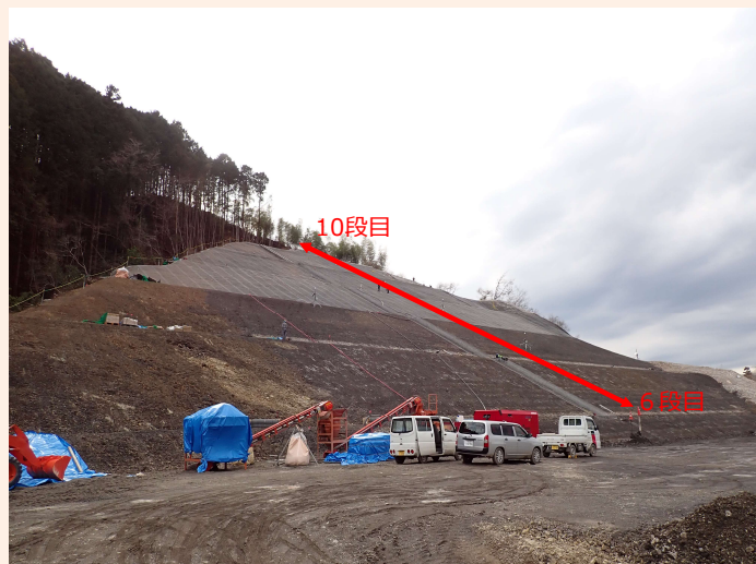
南側斜面の整備状況（令和7年3月3日撮影）
