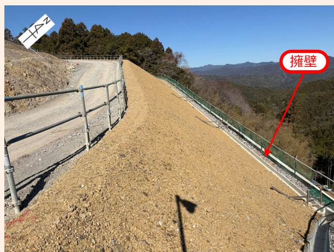
擁壁上部の整備状況（令和8年3月11日撮影）
