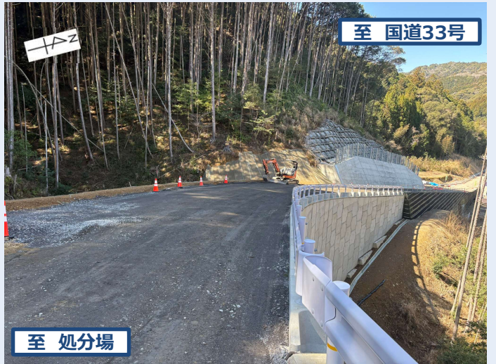
国道から約250m付近の整備状況（令和8年3月11日撮影）
