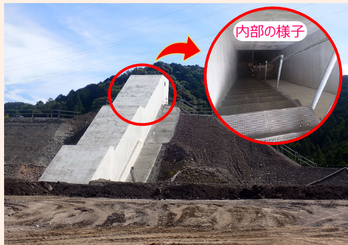
集水ピットの状況（令和7年9月3日撮影）
