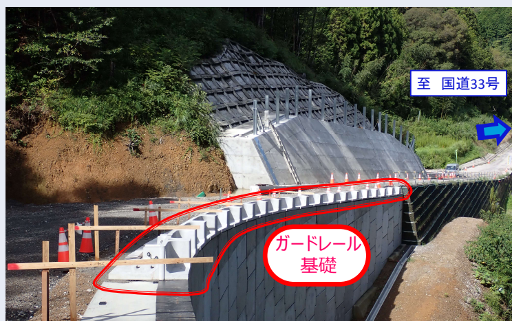
処分場側から見た状況（令和7年9月3日撮影）
