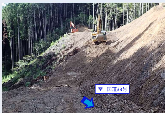
国道33号側から見た状況（令和7年9月5日撮影）
