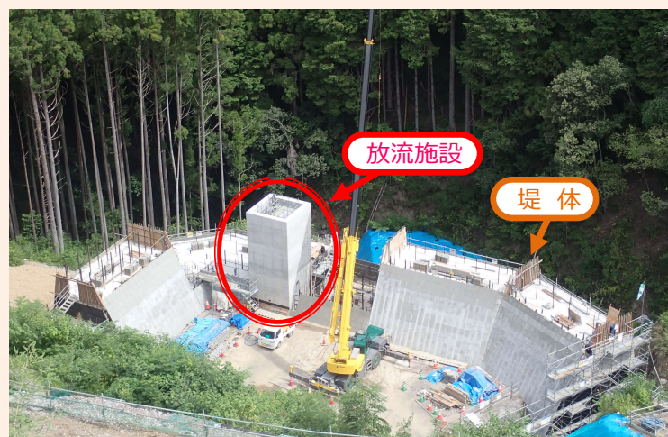
放流施設の施工状況（令和7年9月3日撮影）
