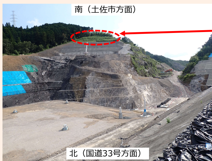
埋立予定地を北側から見た状況（令和7年8月14日撮影）
