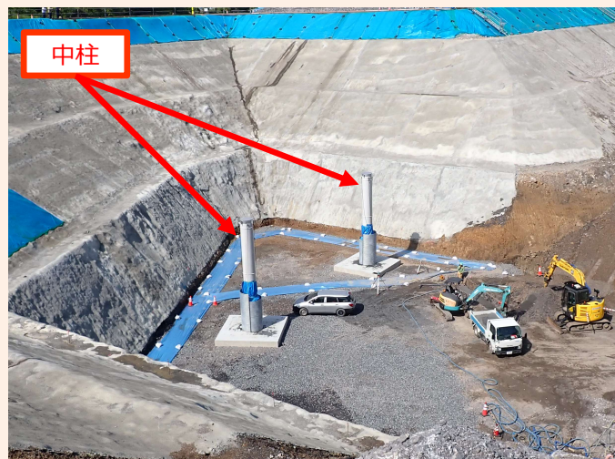
埋立地内の中柱建設状況（令和7年5月12日撮影）
