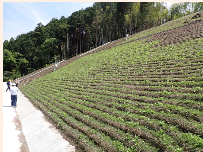
南側斜面の状況（令和7年5月12日撮影）
