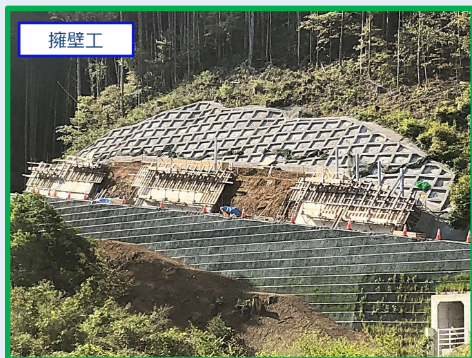
擁壁工の状況（令和7年5月13日撮影）
