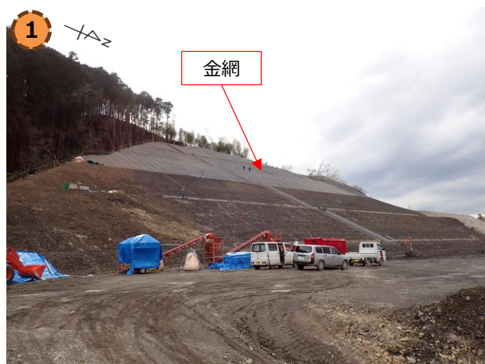
南側斜面上部の整備状況（令和7年3月3日撮影）
