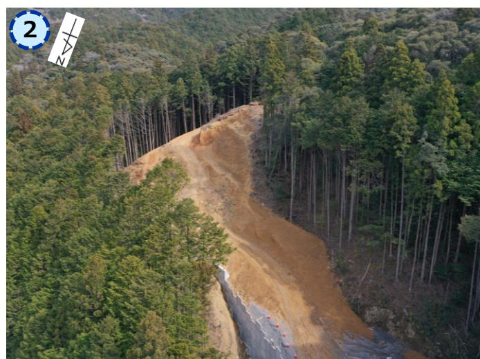
工事区域（奥側）の状況（令和7年3月10日撮影）
