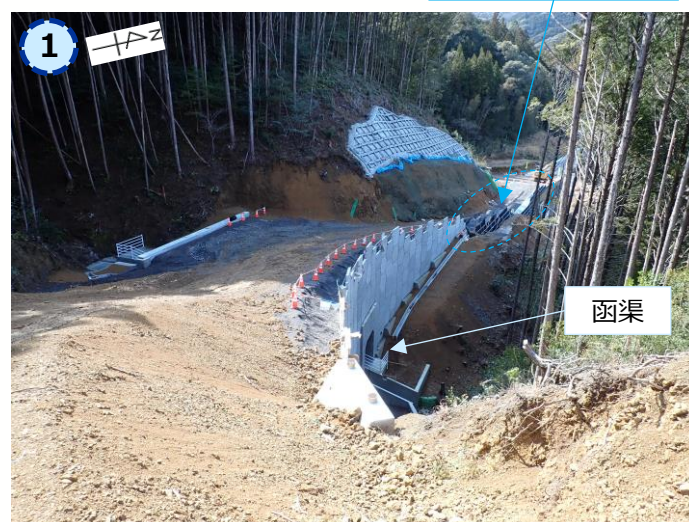
函渠周辺の整備状況（令和7年3月3日撮影）
