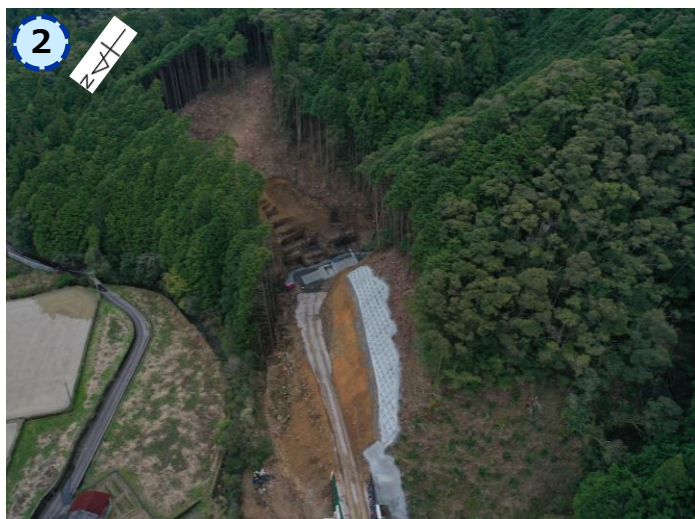
工事区域（奥側）の状況（令和6年4月5日撮影）
