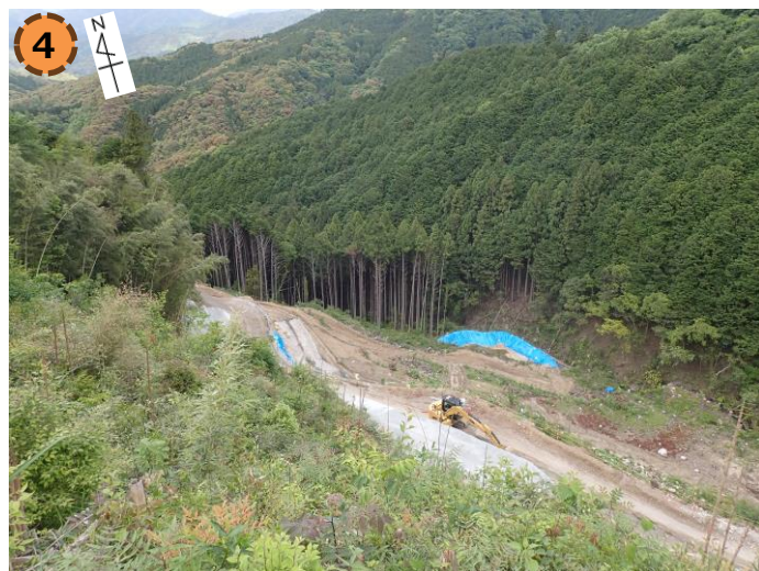
防災調整池までの進入道路の整備状況（令和6年5月5日撮影）
