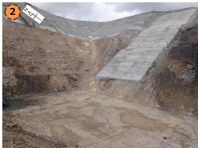
集水ピット周辺の整備状況（令和6年5月5日撮影）
