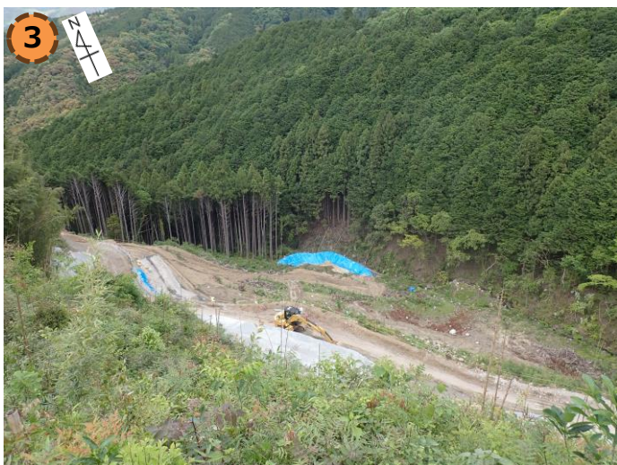
防災調整池付近の整備状況（令和6年5月5日撮影）
