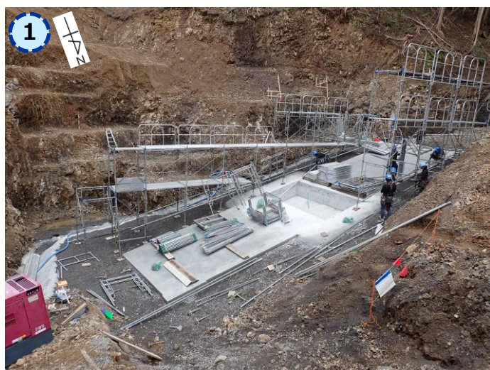
函渠周辺の整備状況（令和6年4月8日撮影）
