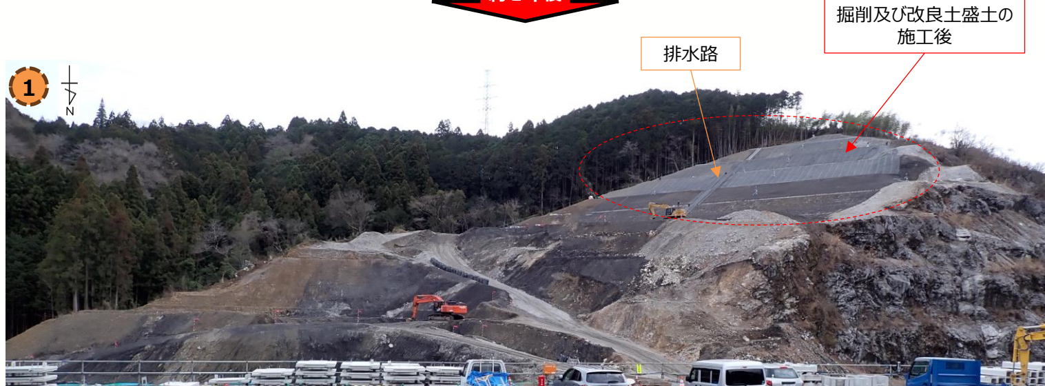
南側斜面の掘削状況（令和7年3月3日撮影）
