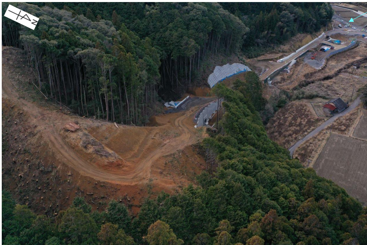
工事区域を北東側上空から見た状況（令和7年2月4日撮影）
