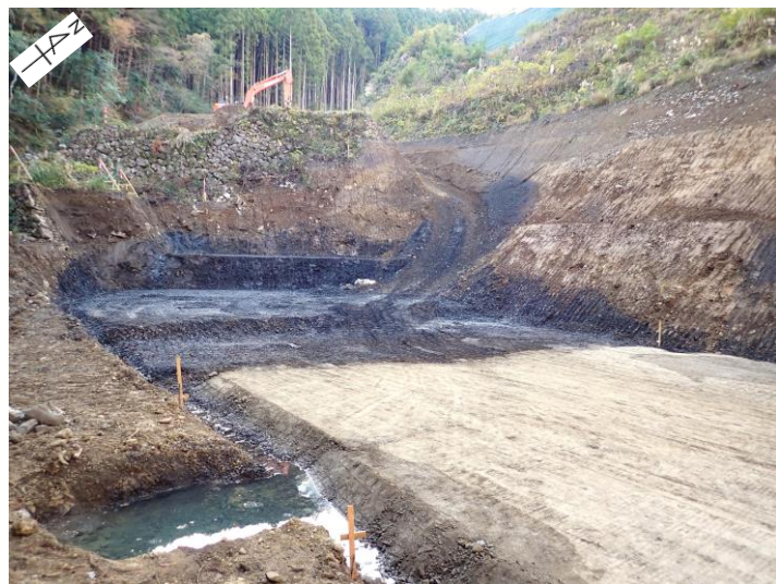
防災調整池付近の掘削状況(令和6年12月12日撮影)
