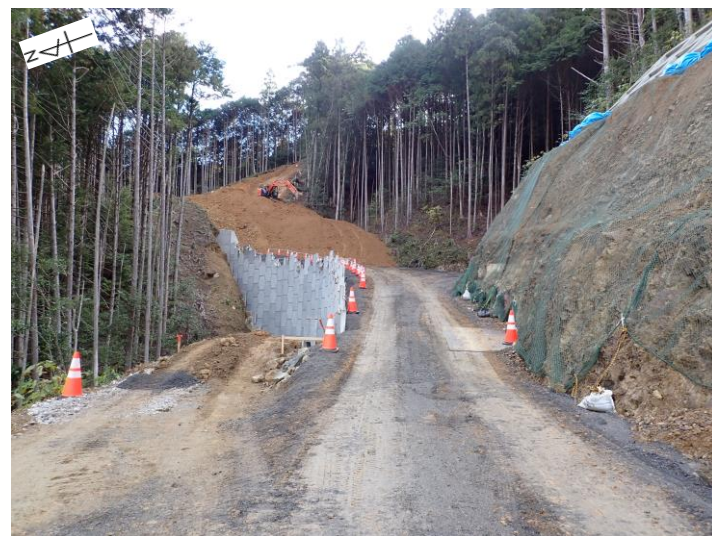
入口(国道33号側)から見た状況(令和6年12月12日撮影)
