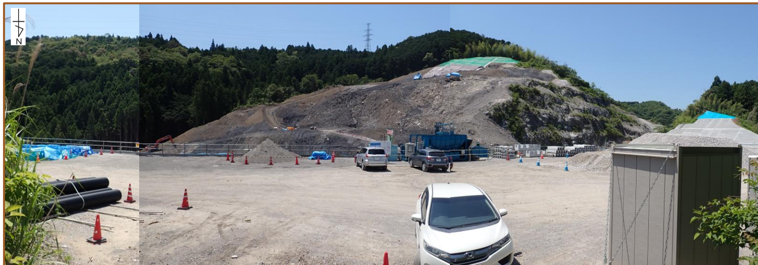
令和6年6月 (Vol.23) 掲載 見直し前の南側斜面の状況 (令和6年6月13日撮影)
