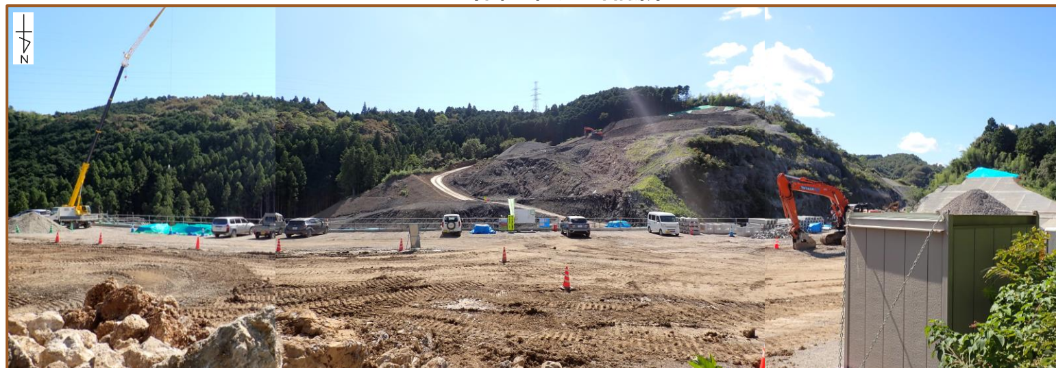
見直し後の南側斜面の掘削状況 (令和6年10月10日撮影)
