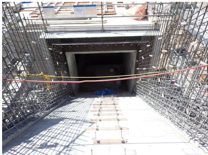
集水ピット入口の整備状況（令和6年9月13日撮影）
