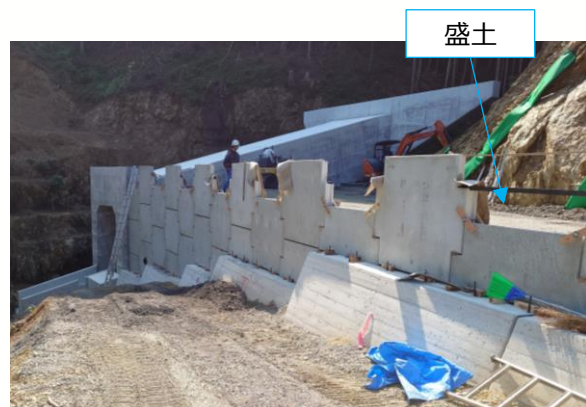
補強土壁工の整備状況（令和6年9月9日撮影）
