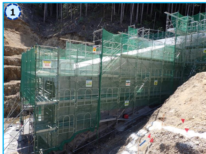
函渠の整備状況（令和6年6月13日撮影）
