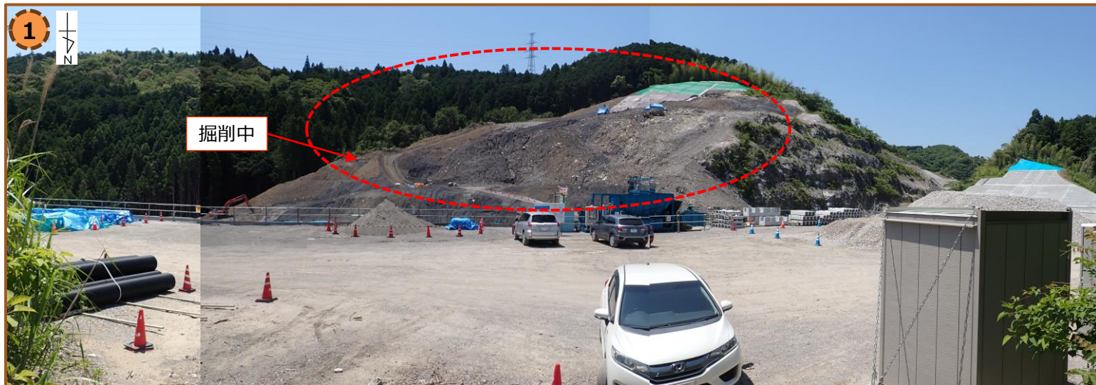
南側斜面の掘削状況（令和6年6月13日撮影）
