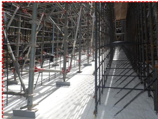
函渠内の鉄筋設置の状況（令和6年5月5日撮影）
