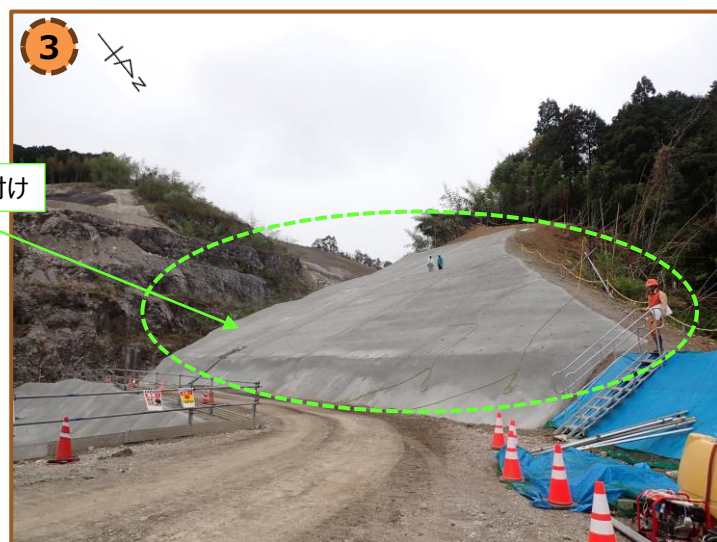
北西側の整備状況（令和6年4月8日撮影）
