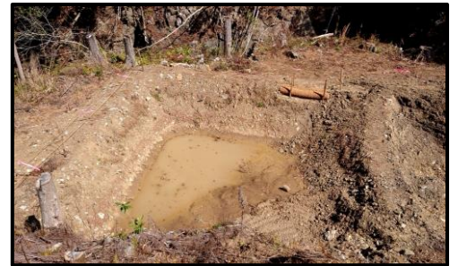
沈砂池（令和6年3月10日撮影）
