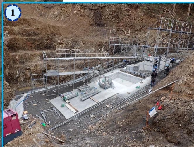
函渠の整備状況（令和6年4月8日撮影）
