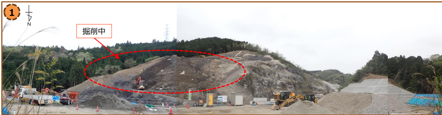
南側斜面の掘削状況（令和6年4月8日撮影）
