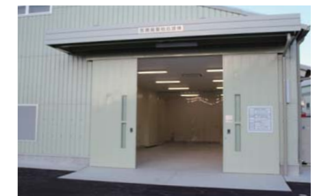
▲医療廃棄物処理施設保管室
